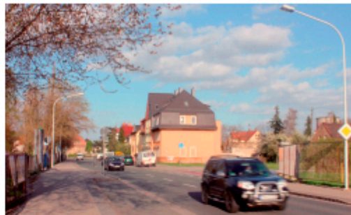
Im Bereich der Paul-Greifzu-Straße finden 2012/13 wesentliche Maßnahmen für Riasas Infrastruktur statt. Fotos U.P.
